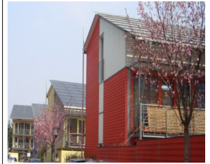
A FRIEBOURG, des maisons recouvertes de panneaux solaires. Un quartier en énergie positive.
